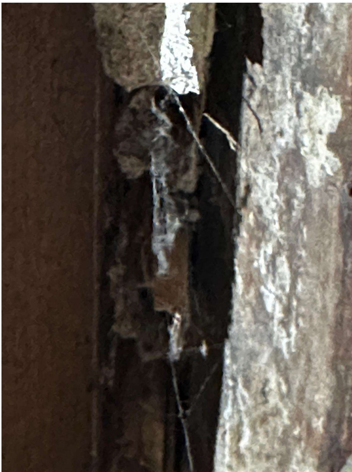
Fot. 6 – Widoczne pozostałości maty trzcinowej w nadprożu nad wejściem z pokoju do poddasza nieużytkowego przy pokojach
