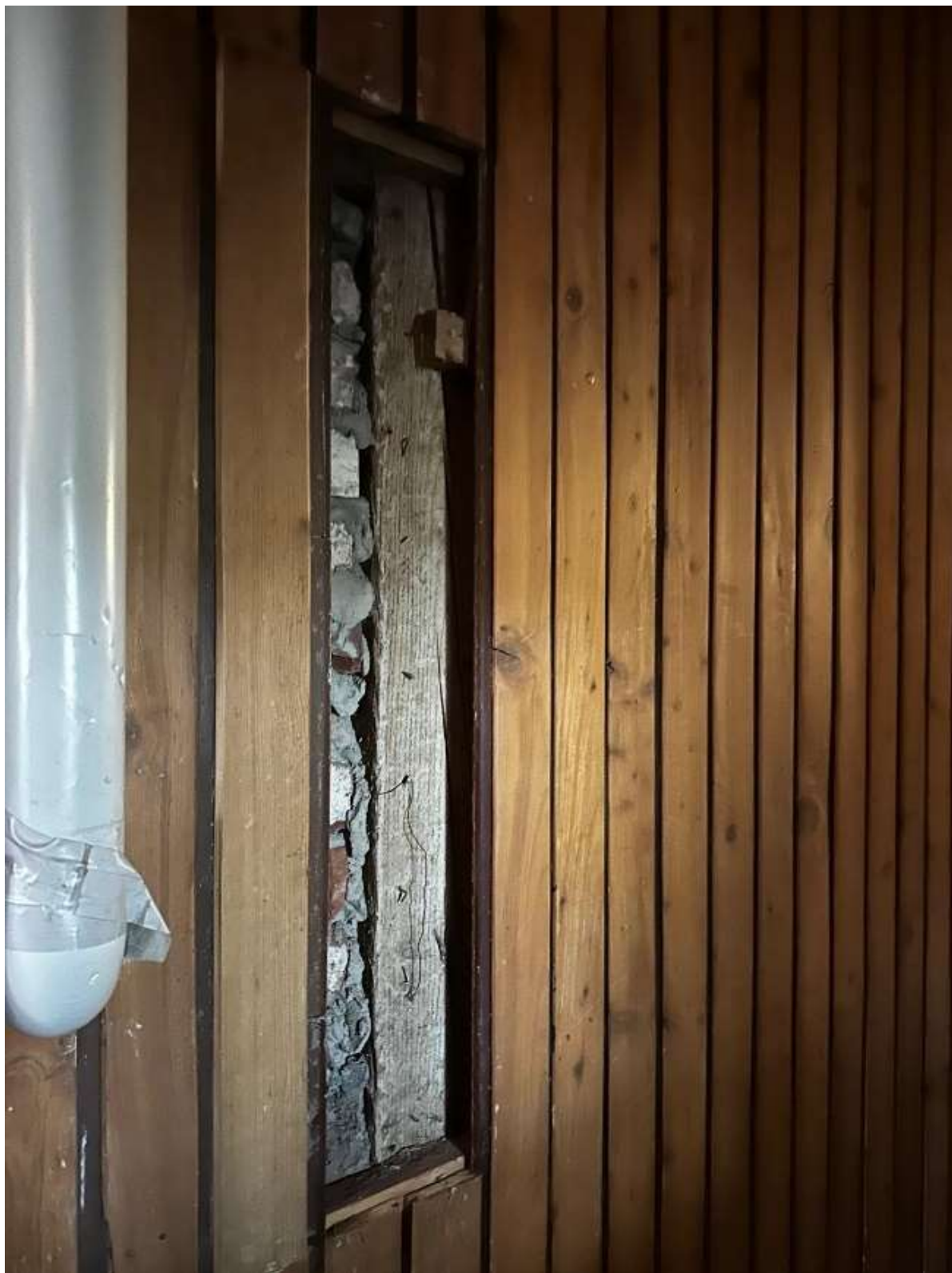
Fot. 2 – Widok na słup drewniany w ścianie szachulcovej, widoczne pozostałości po montażu maty trzcinowej
