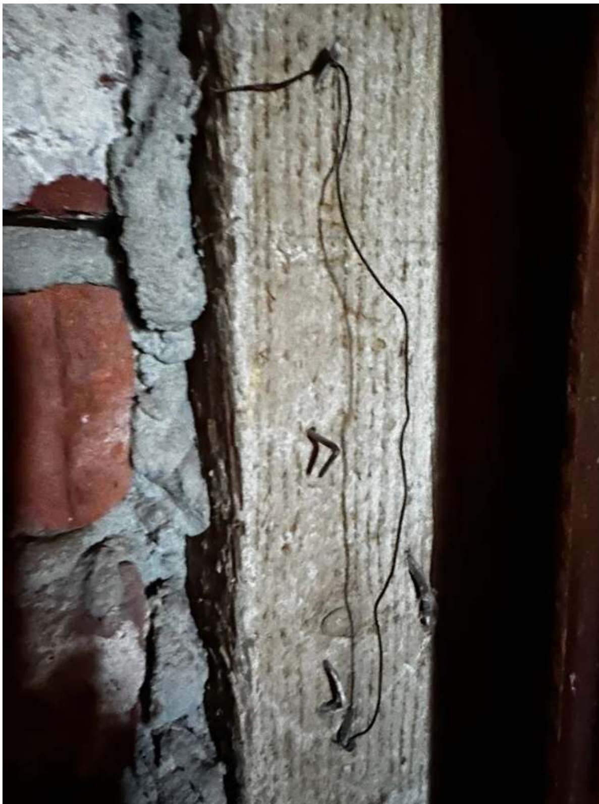
Fot. 1– Widok na słup drewniany w ścianie szachulcowej, widoczne pozostałości po montażu maty trzcinowej
