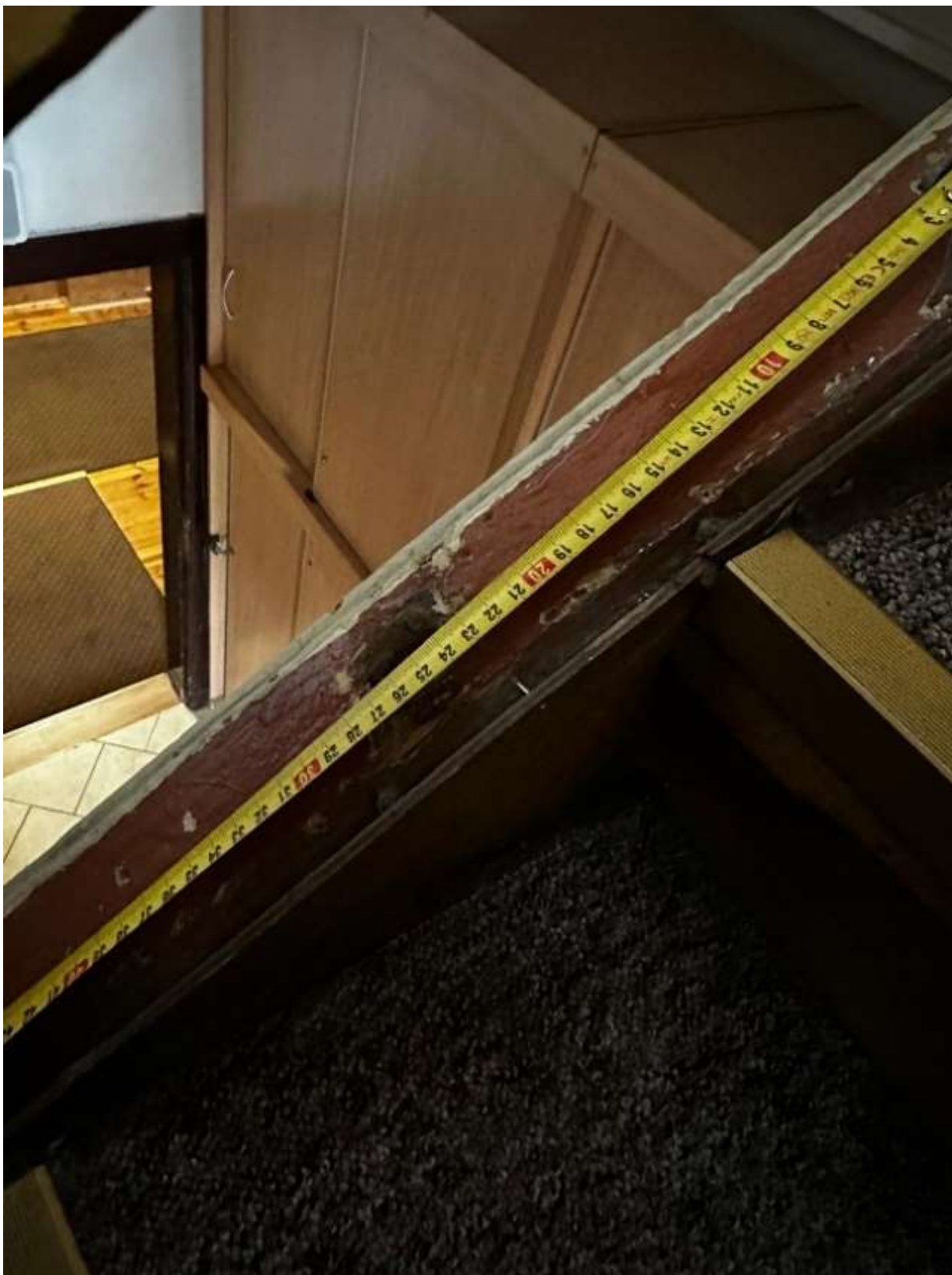
Fot. 22 – Widoczne otwory w belce polickowej po oryginalnych tralkach. Rozstaw otworów to ok. 25 cm.
