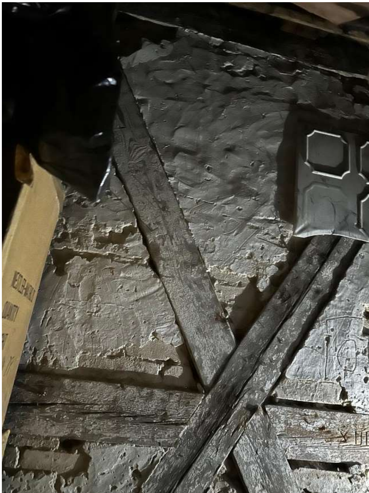
Fot.8 – Widok na oryginalną ścianę szachulcową od strony poddasza nieużytkowego
