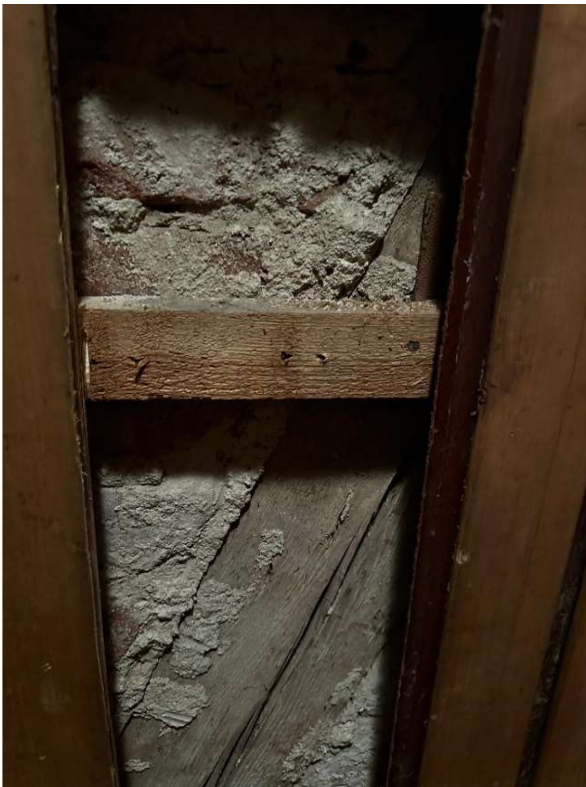
Fot.4 – Widocznełaty pod montaż boazerii
