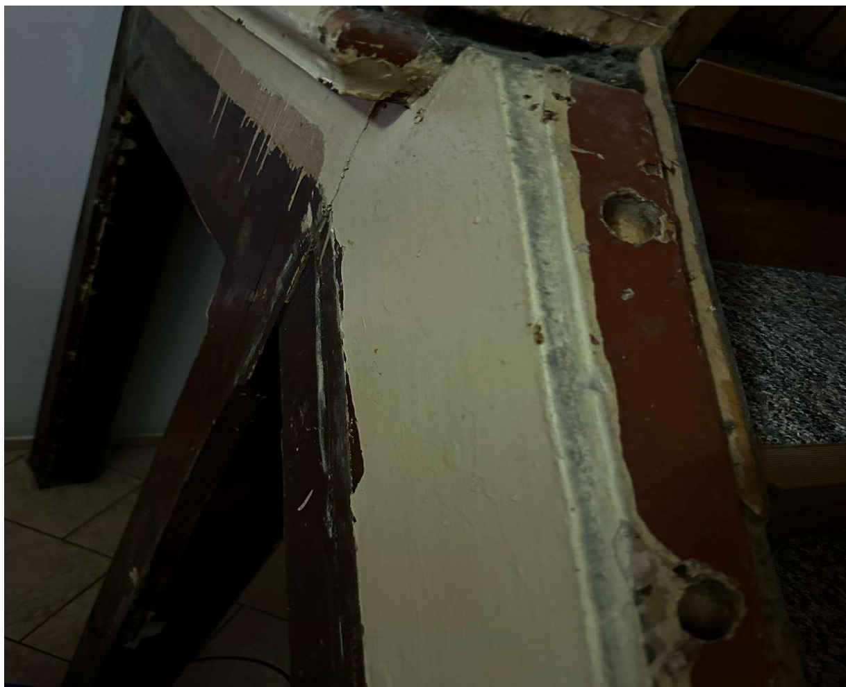
Fot.21 – Widoczne otwory w belce policzkowej po oryginalnych tralkach. Rozstaw otworów to ok. 25 cm.
