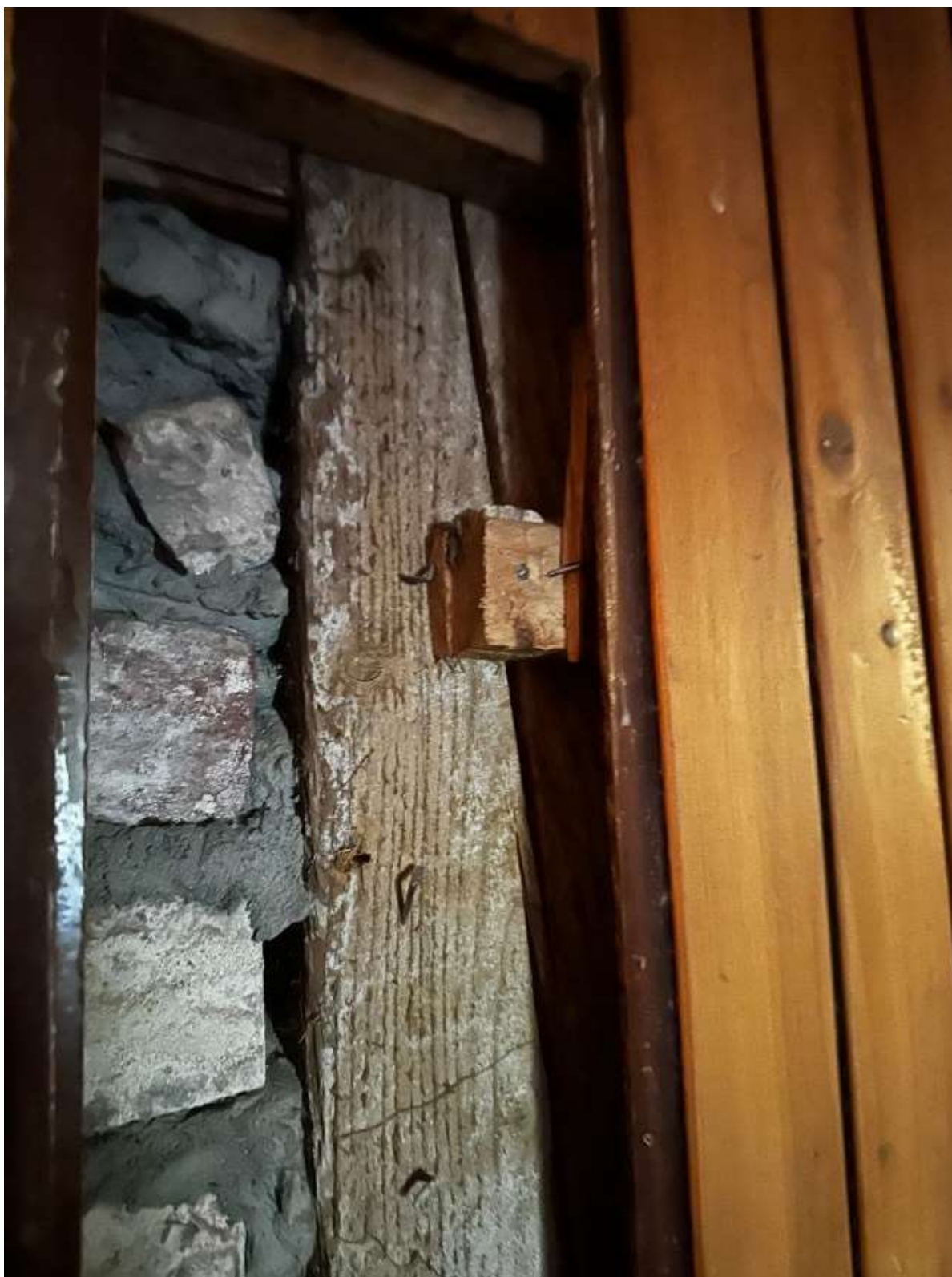
Fot.3 – Widoczne na słupie pozostałości po tynku wapiennym
