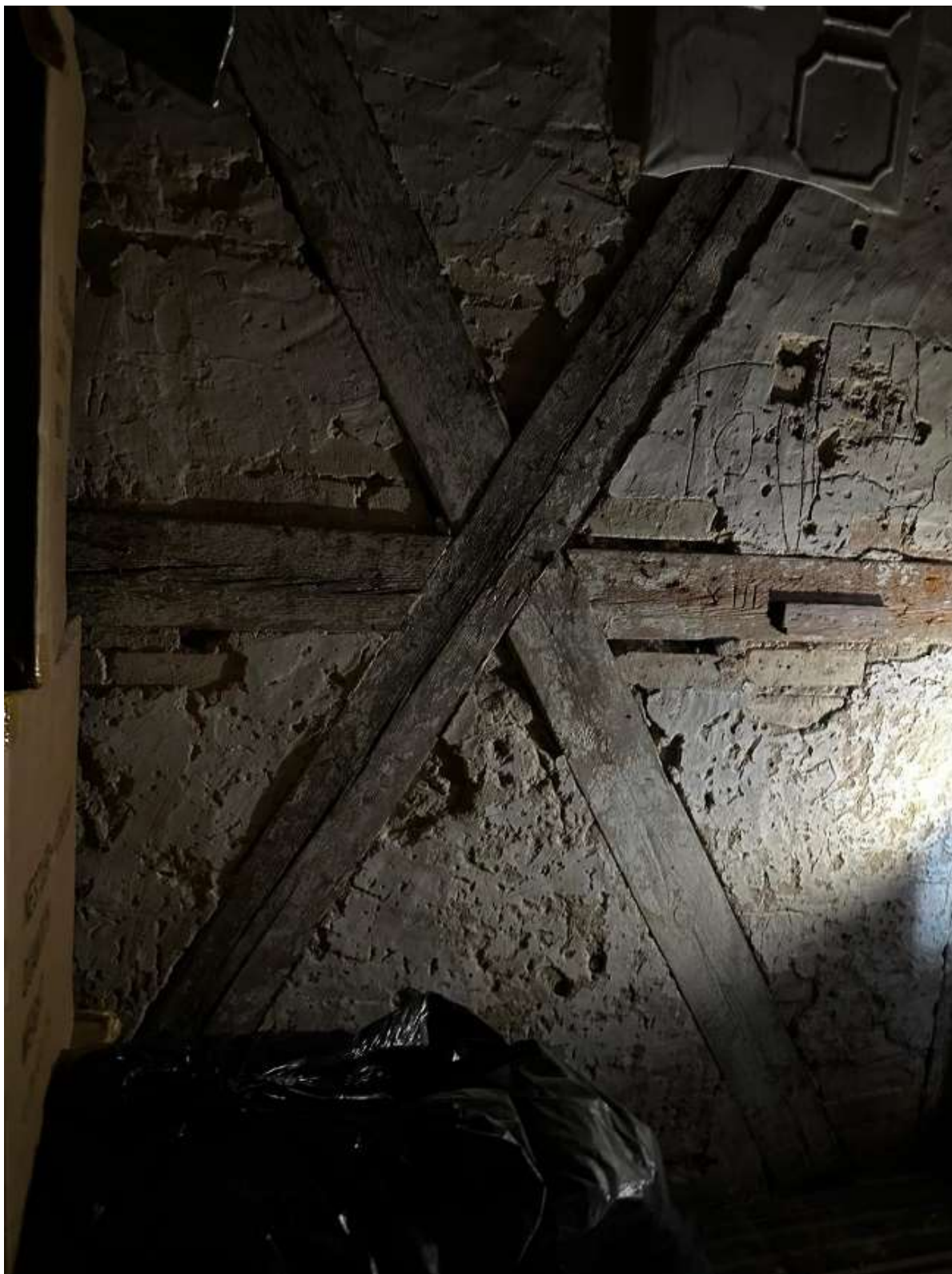
Fot. 7 – Widok na oryginalną ścianę szachulcową od strony poddasza nieużytkowego
