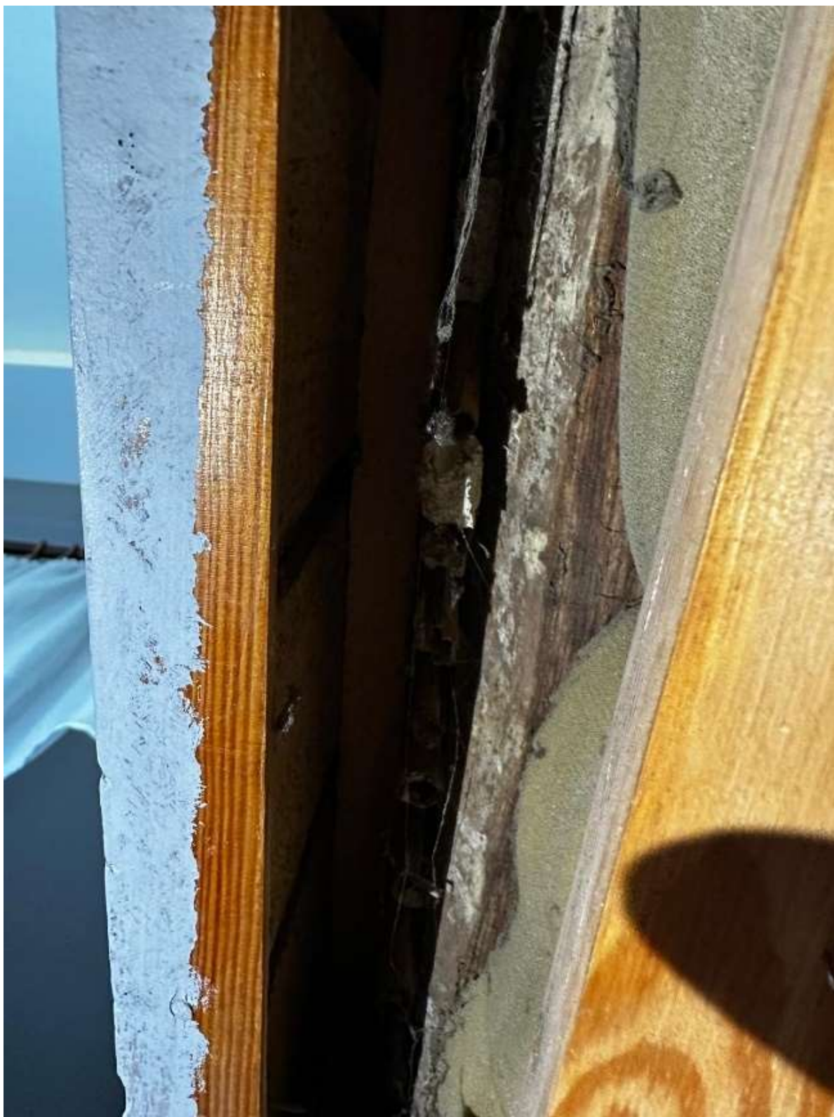
Fot. 5 – Widoczne pozostałości maty trzcinowej w nadprożu nad wejściem z pokoju do poddasza nieużytkowego przy pokojach
